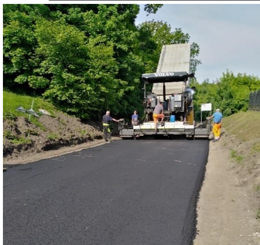
Remont drogi Bogdanki - Szonowo Szlacheckie - Plesewo
