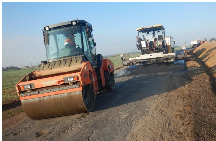
Przebudowa z rozbudową drogi Bukowiec- Stare Błonowo
