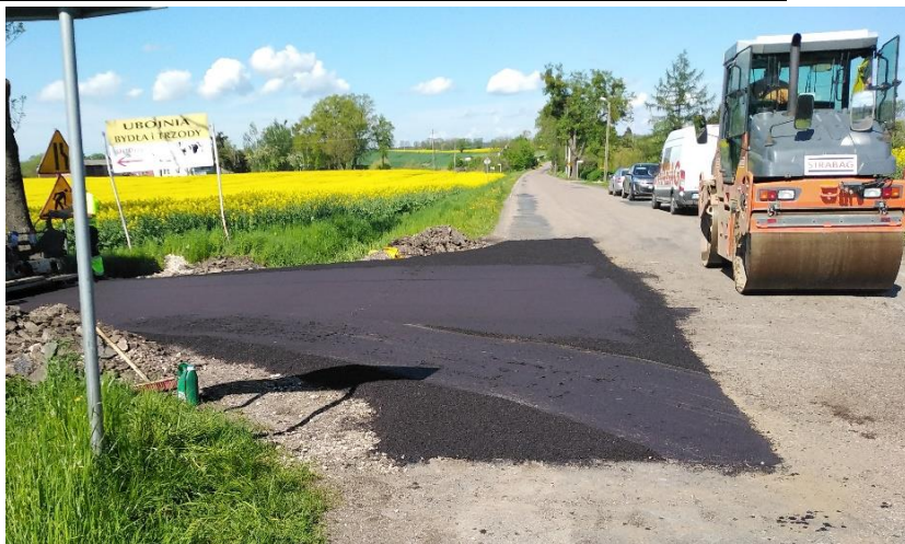
Remont drogi Szembruczek- Nowe Mosty
