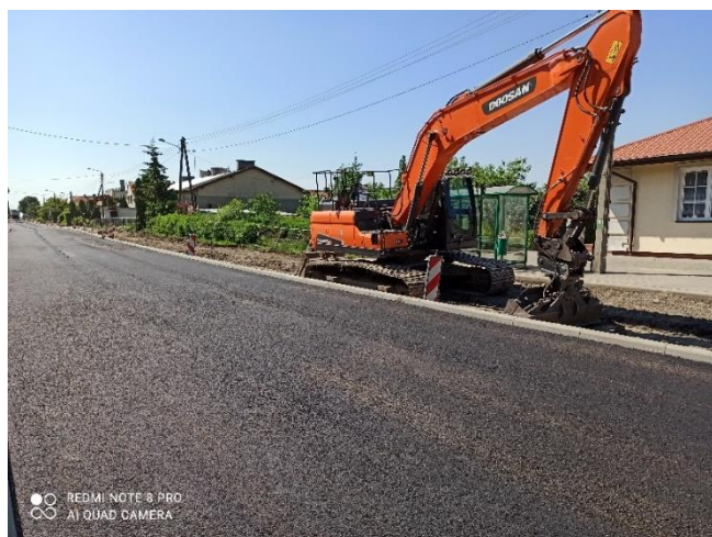
Przebudowa drogi Dąbrówka Królewska – Gruta
