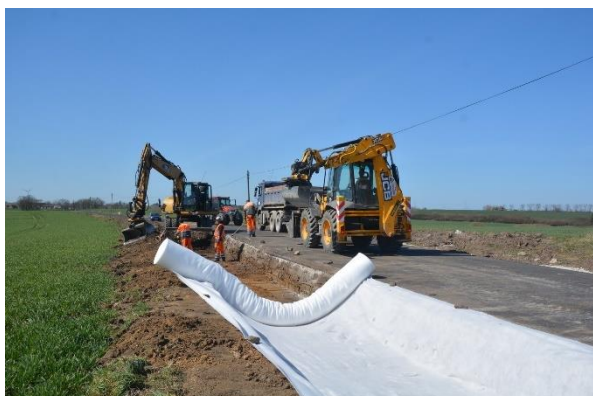
Przebudowa drogi powiatowej nr 1416C Zielnowo - Fijewo
