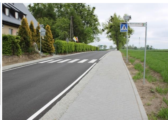
Przebudowany odcinek drogi powiatowej nr 1383C Dąbrówka Królewska- Gruta
