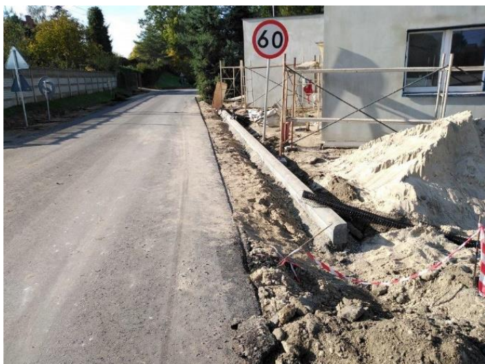
Remont drogi powiatowej nr 1389C Bogdanki - Szonowo Szlacheckie - Plesewo
